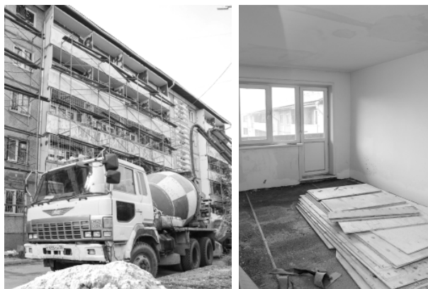
Идет ремонт общежития 11 «А»
