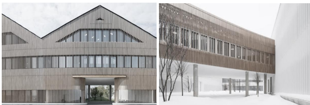
Рис. 14. Отделка фасадов здания
