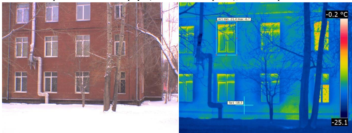
Фото и термо 8. Учебный корпус (западный торец), левая сторона 1 и 2 этажи
