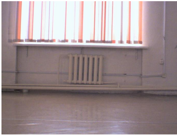
Фото и термо 26. Пример «забитых» отопительных приборов актового зала
