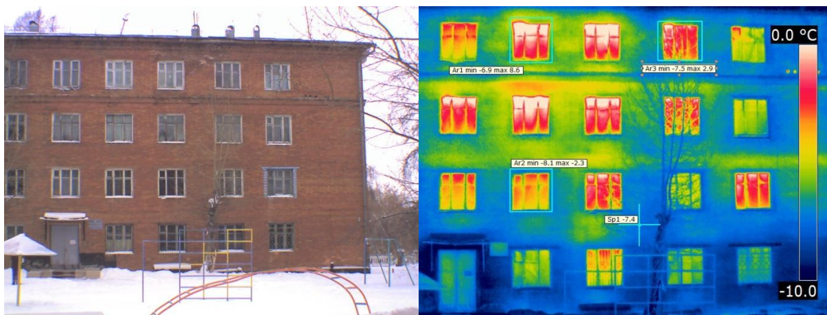
Фото и термо 1. Правая часть (юго-западный фасад)
