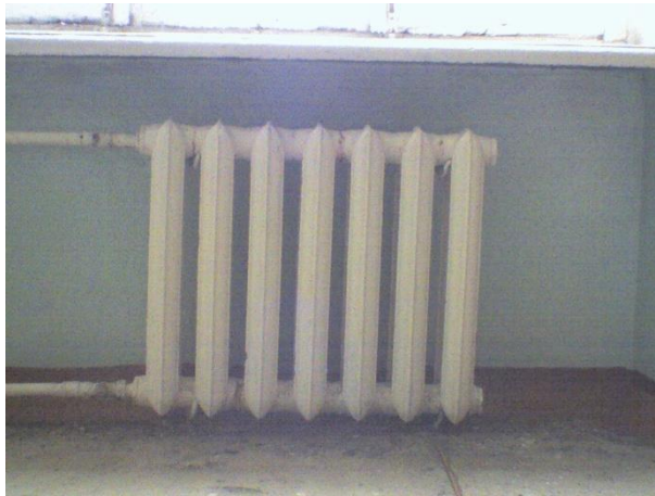
Фото и термо 28. Пример «забитых» отопительных приборов в коридоре
