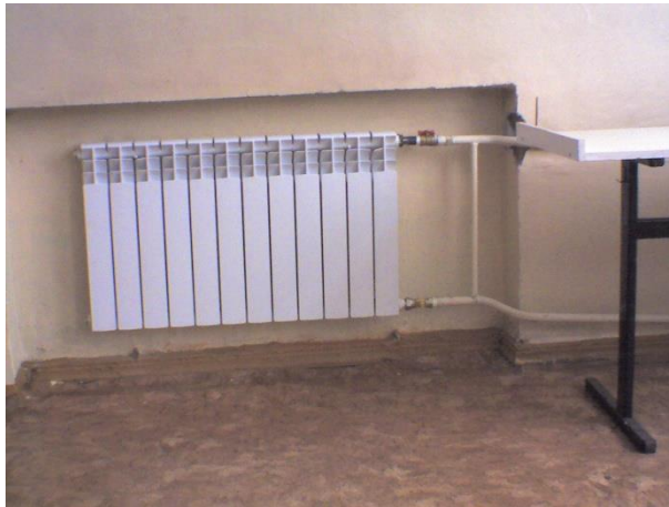
Фото и термо 28. Пример «забитых» отопительных приборов в коридоре
