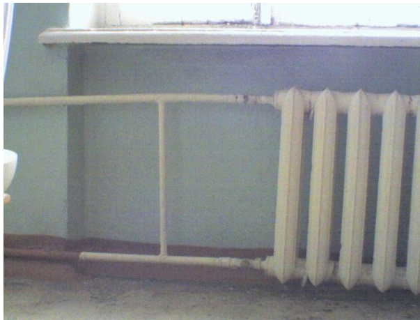
Фото и термо 27. Пример «забитых» отопительных приборов в коридоре
