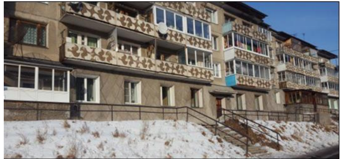
Рисунок А.2 Фасад существующего жилого дома
