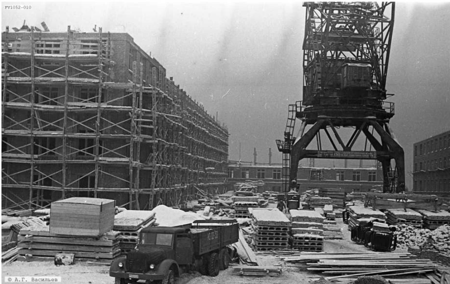
Строительство Студенческого городка / фот. А. Г. Васильев. - [1956-1957]
