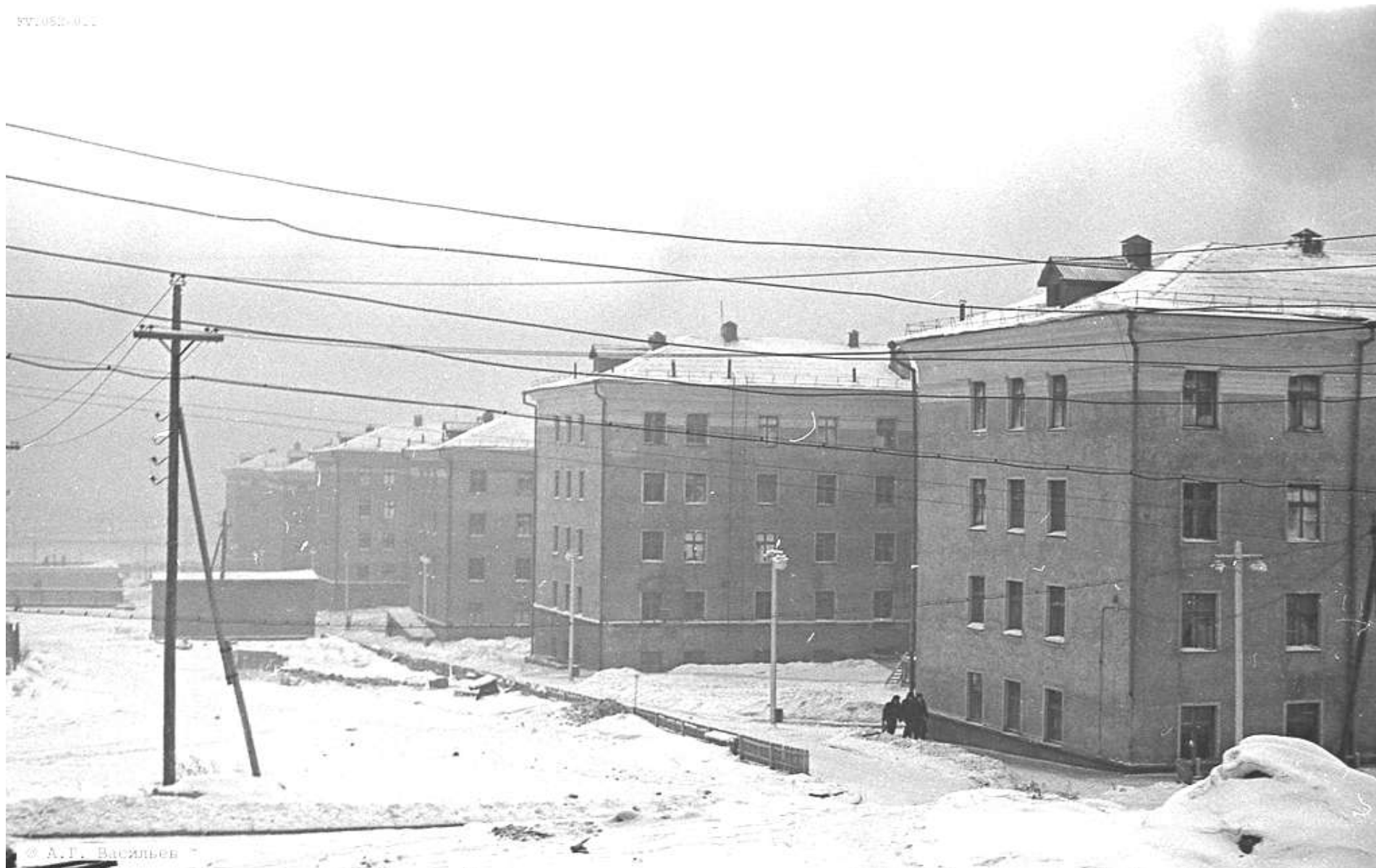
Строительство Студенческого городка / фот. А. Г. Васильев. - [1958-1959].
