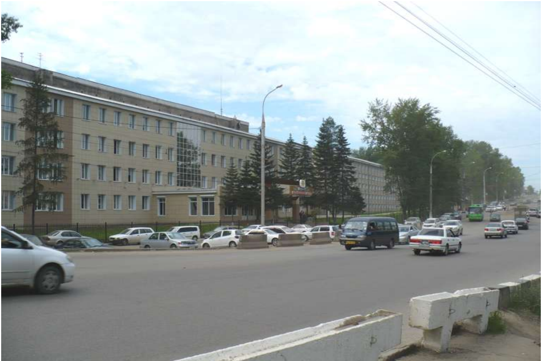
Реконструкция ул. Лермонтова 01.07.2008 г.
