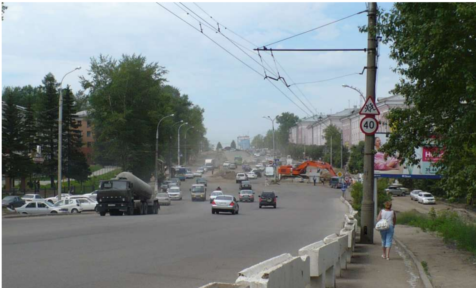
Реконструкция ул. Лермонтова. Строится подземный переход 01.07.2008 г.
