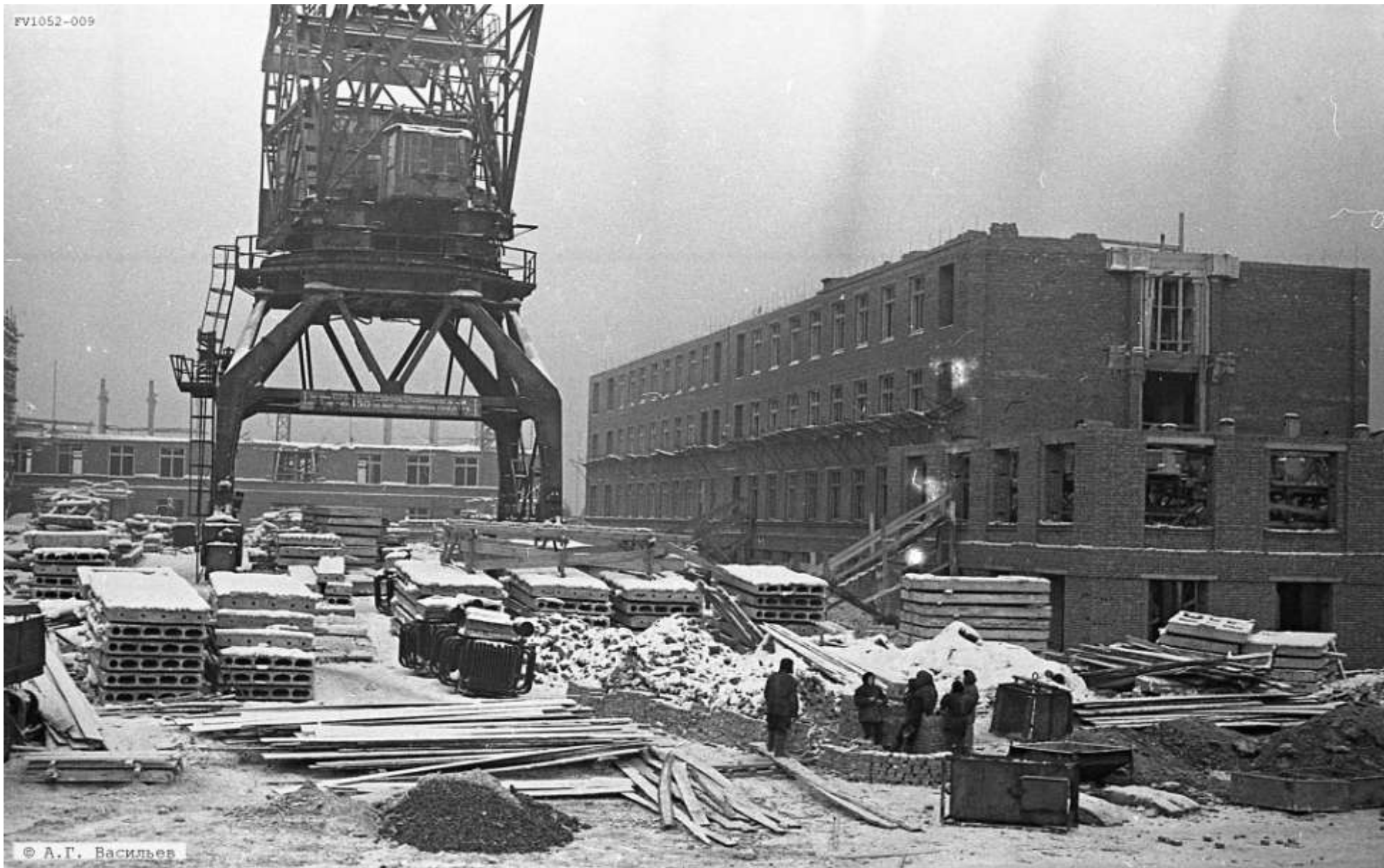
Строительство Студенческого городка / фот. А. Г. Васильев. - [1956-1957]
