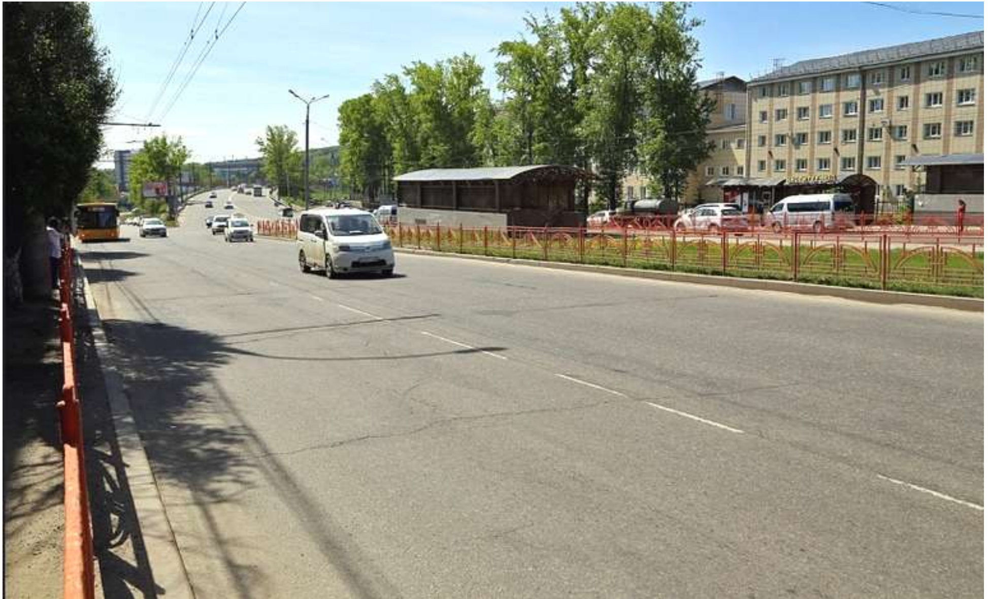
Ул. Лермонтова, вид на виадук через Транссиб. Справа институт МВД Ремонт проблемных участков дорог стартовал в Иркутске https://irkutsk.bezformata.com/listnews/uchastkov-dorog-startoval-v-irkutske/57547068/
