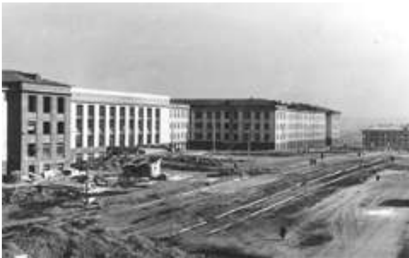
Строительство студгородка (1950е)
