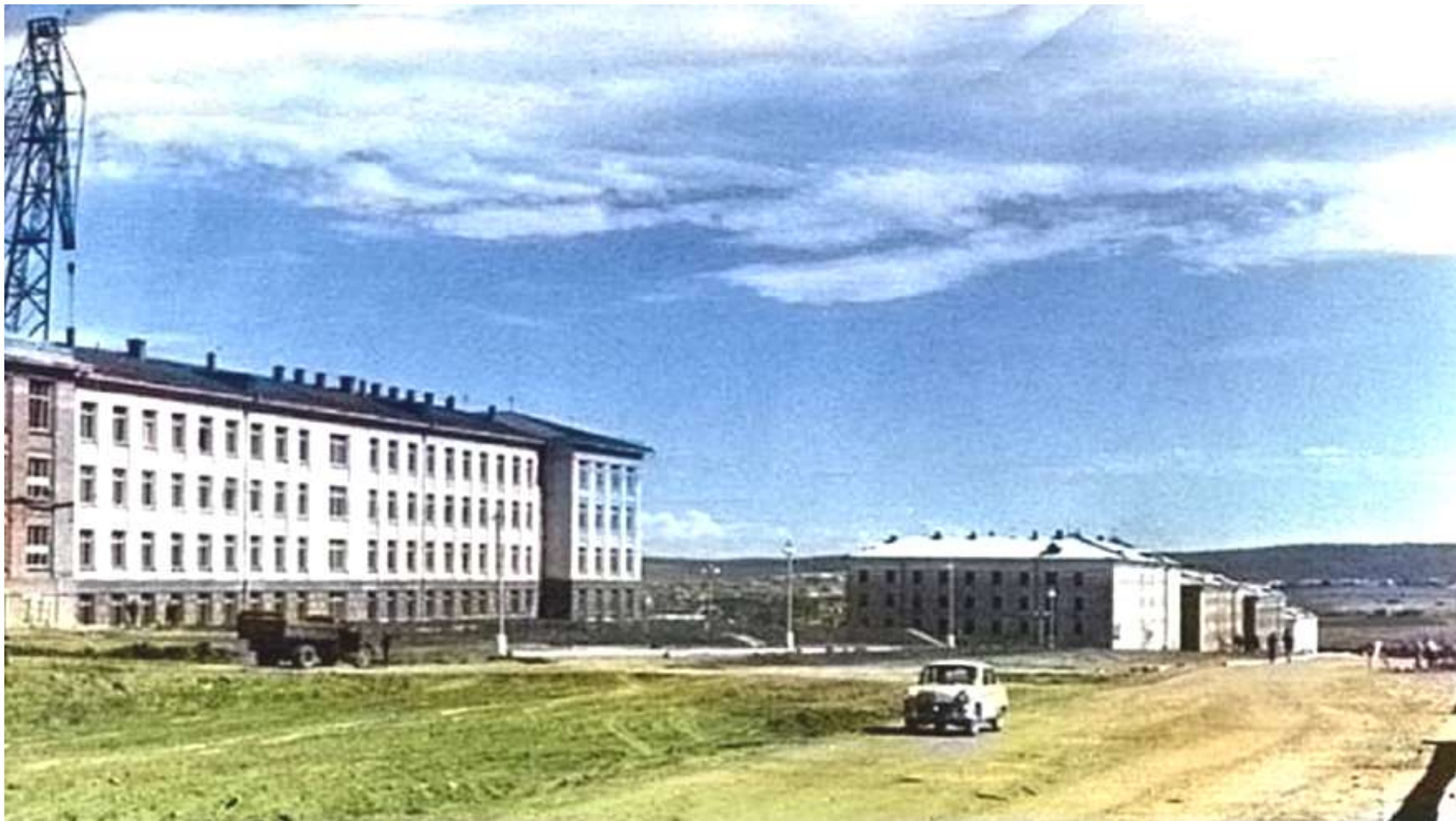
Строительство Политехнического института Примерно 1960 - 1961 годы Видна коробка общежития № 4, на ул. Курчатова можно разглядеть только дом № 5. Автор: Белоколодов Виталий Николаевич Источник: http://irkipedia.ru/guide/picture.php?/4746/category/228 https://vk.com/wall-30983253_12666 https://pastvu.com/p/831098
