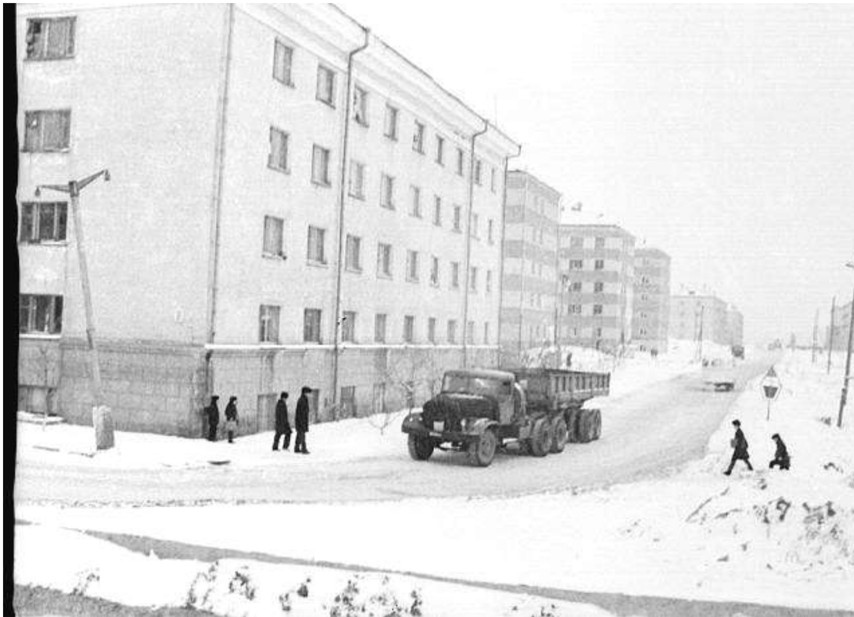
Улица Курчатова, выезд на ул. Лермонтова. 1968 г. - примерно (дома № № 2, 4, 6 по Курчатова - год сдачи 1968)
