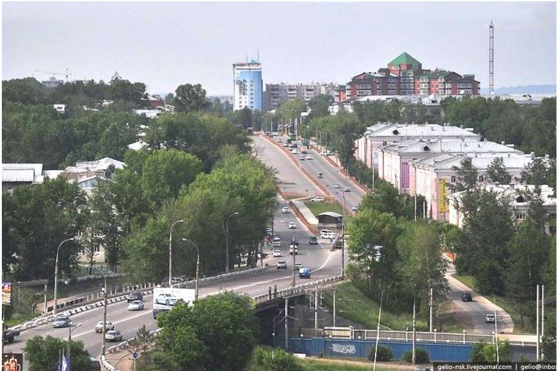
Ул. Лермонтова. Вид на виадук через Транссиб. 2010 г. Иркутские крыши. БЦ "Академический" [10эт.] (2010) https://my-irkutsk.livejournal.com/98263.html?view=comments
