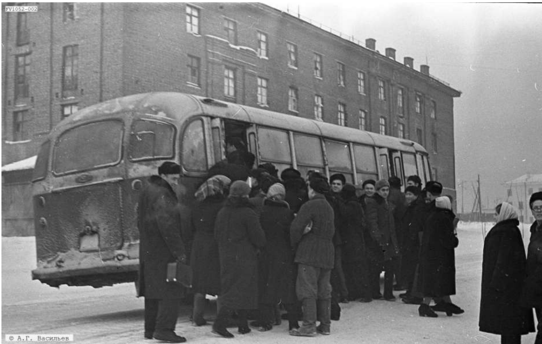
Строительство Студенческого городка / фот. А. Г. Васильев. - [1956-1957]
