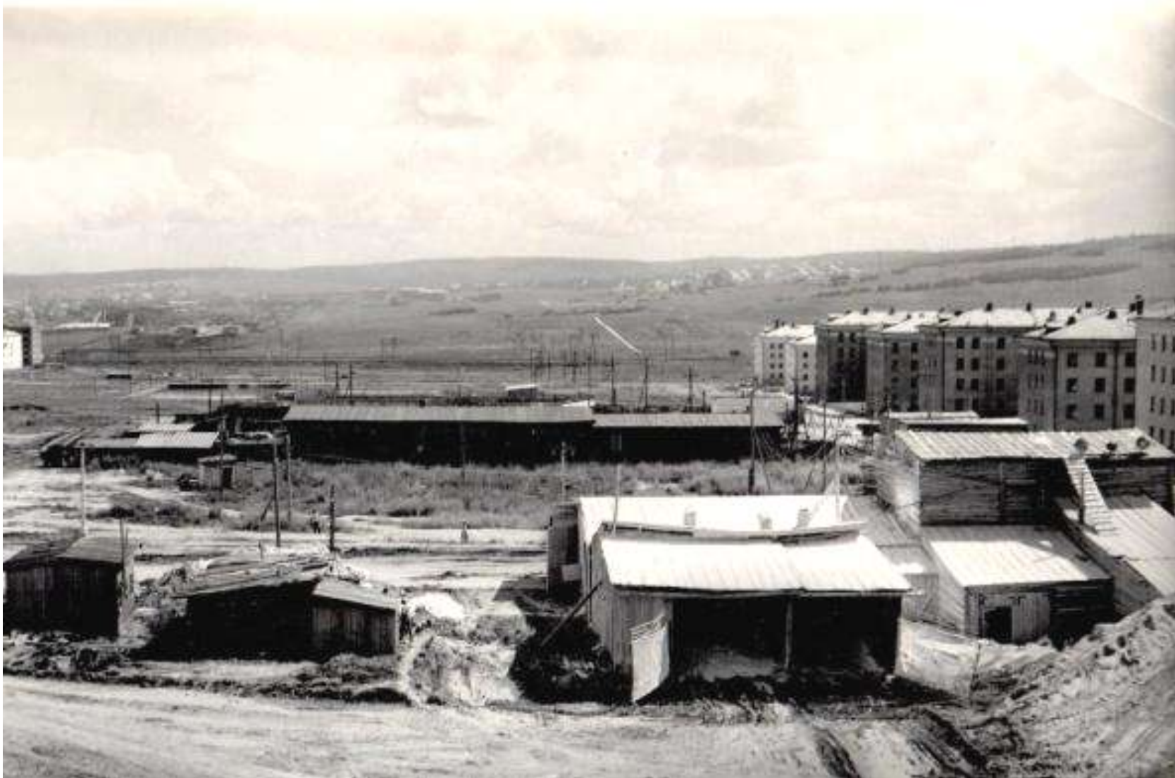
Панорама студгородка со строящегося института
