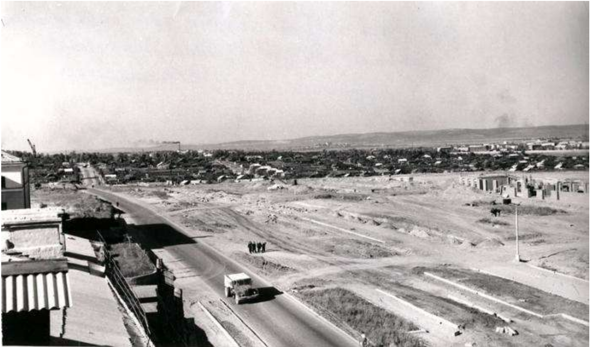
Ул. Лермонтова. Вид в сторону ул. Жуковского. 1959
