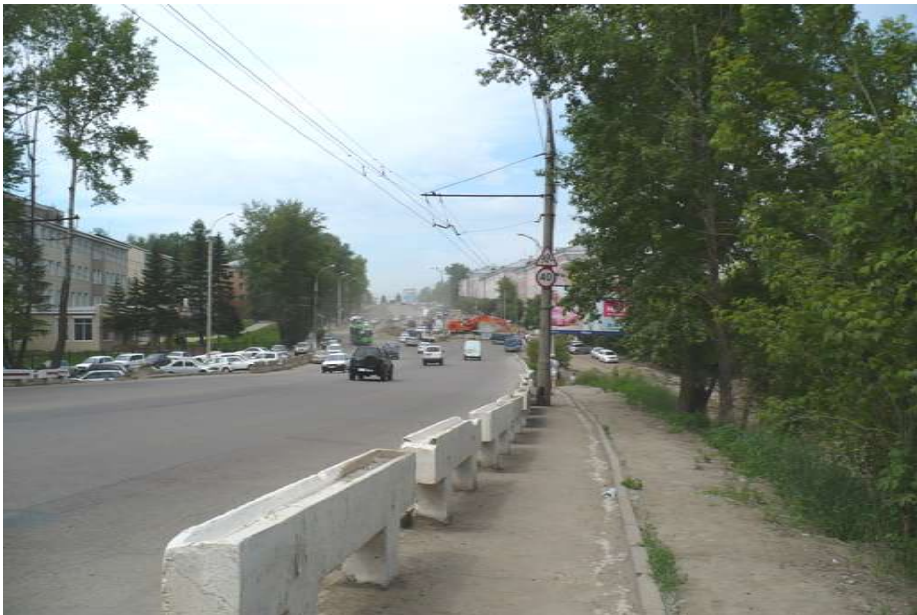
Реконструкция ул. Лермонтова 01.07.2008 г.
