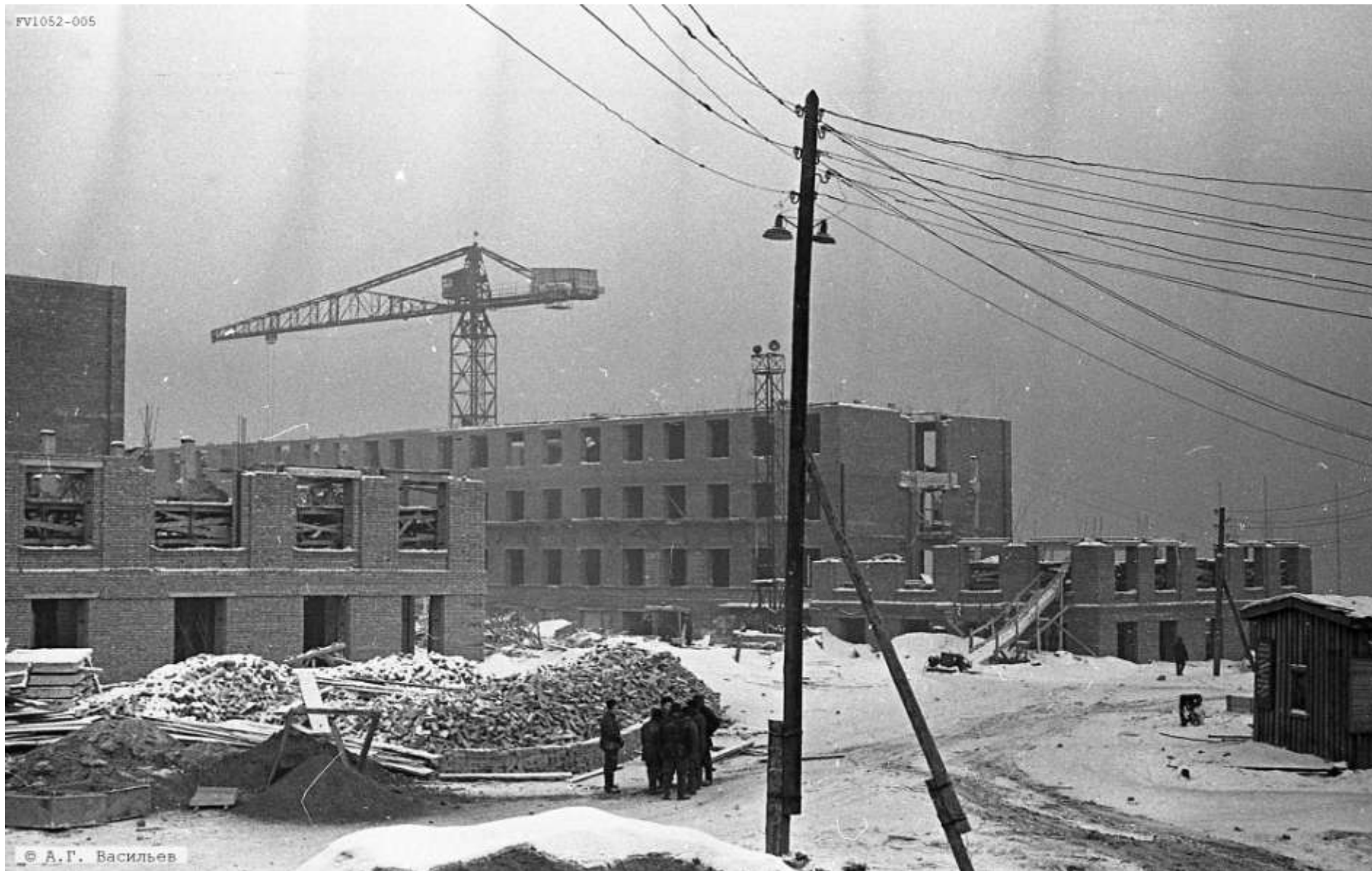
Строительство Студенческого городка / фот. А. Г. Васильев. - [1956-1957]
