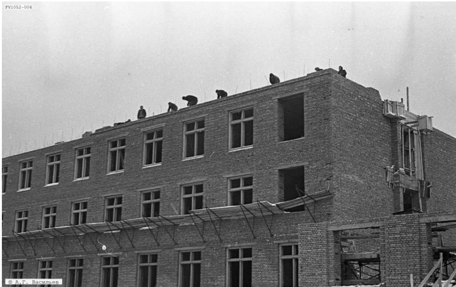
Строительство Студенческого городка / фот. А. Г. Васильев. - [1956-1957]
