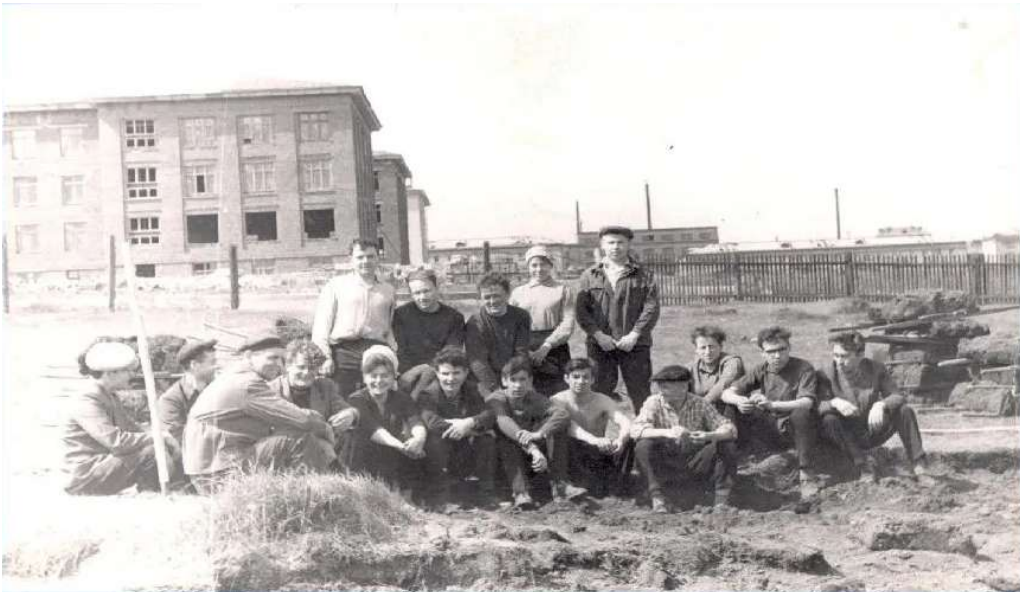
Строятся корпуса Г (ближний к фотографу), В и Б политехнического института 1964 – 66 г.г.
