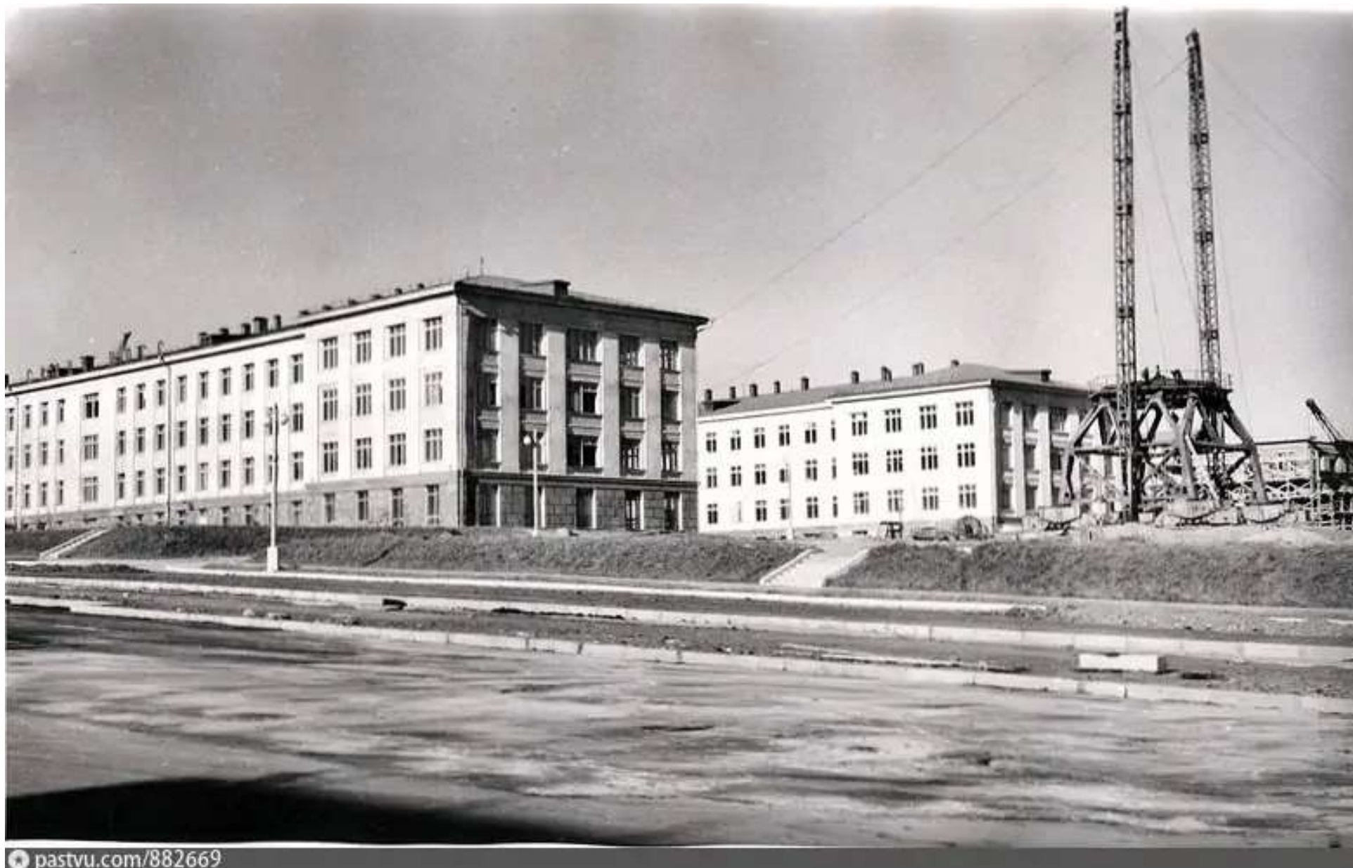
Новые учебные корпуса Политехнического института. 1962 ,
