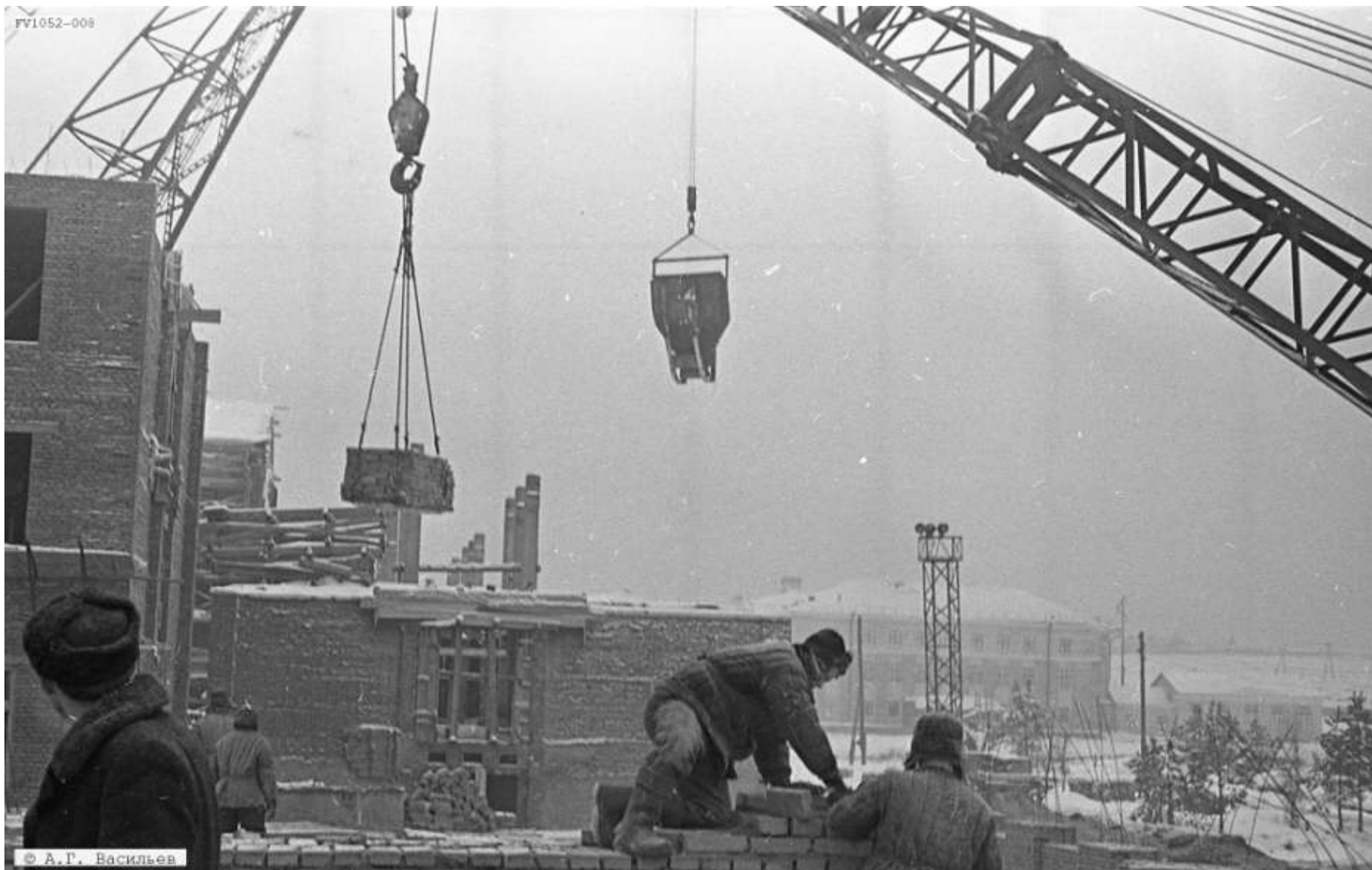
Строительство Студенческого городка / фот. А. Г. Васильев . - [1956-1957] На заднем плане видно трехэтажное здание бывшего ПТУ (Лермонтова, 92)
