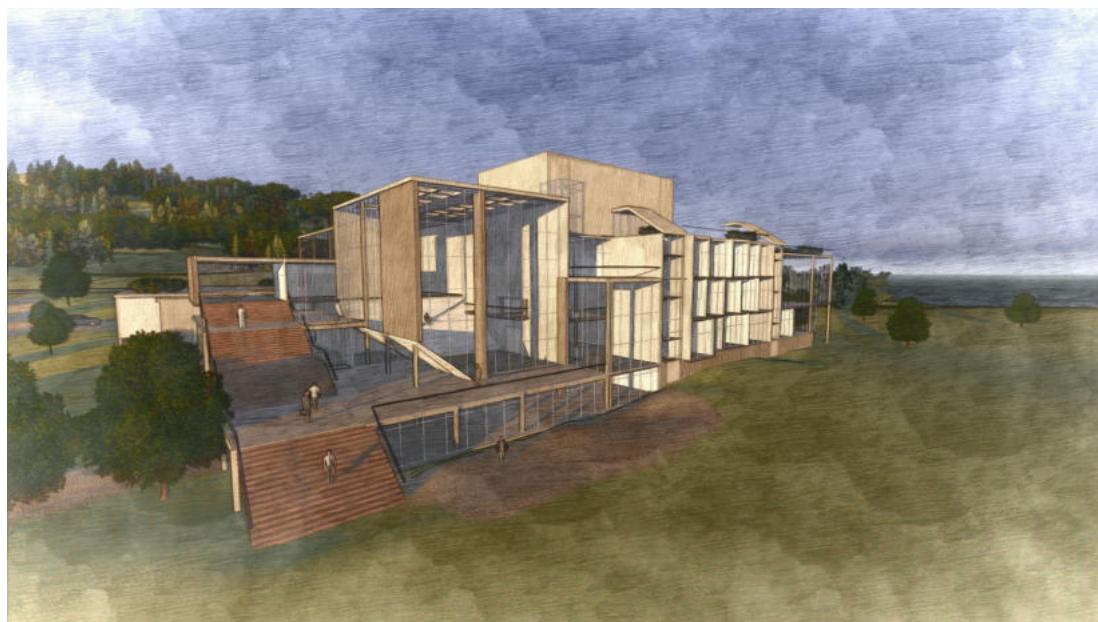
Рис. 48 Вход со стороны набережной.
